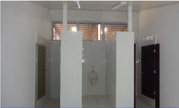
Vista interna del área de servicios sanitarios árbitros - Gradería Este, donde se aprecia la ejecución de las actividades de pisos, lámparas, puertas de aluminio y lámina acrílica rugosa, instalación de aparatos sanitarios.
