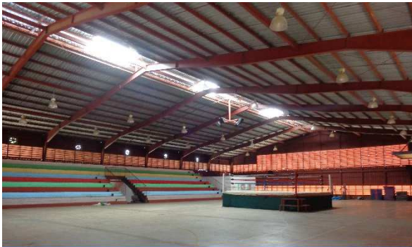
En esta fotografías apreciar las instalaciones del Gimnasio de Combate situación sin proyecto observar panorámica del Gimnasio.
